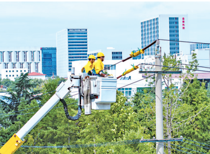
国网青岛供电公司工作人员正在进行带电作业。
