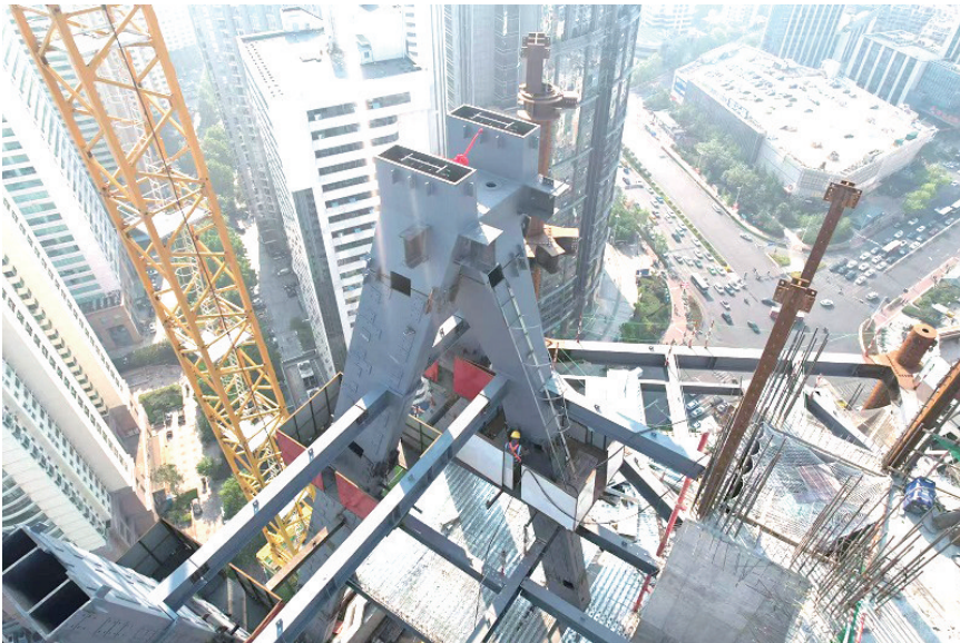
“三柱合一”首吊安装。建设方供图
