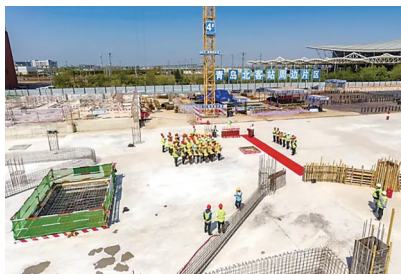
青岛北站东广场地下空间枢纽停车及涉高铁区域主体结构封顶。(地铁供图)
