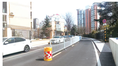
整治后的春光山色片区区间道路。
