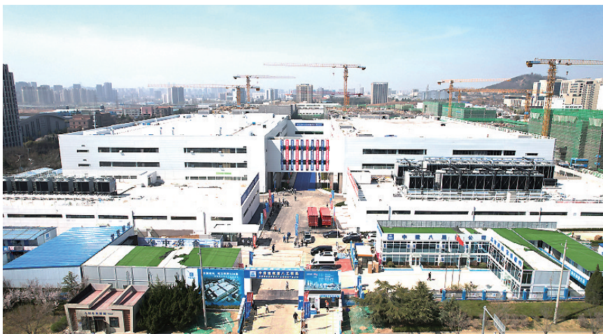
青岛虚拟现实产业园项目一期已交付。
