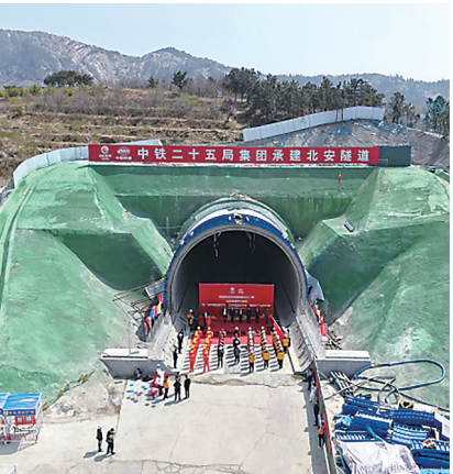
潍宿高铁至青岛连接线首条隧道贯通。(中铁二十五局供图)
