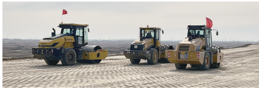
官路水库工程施工现场。
