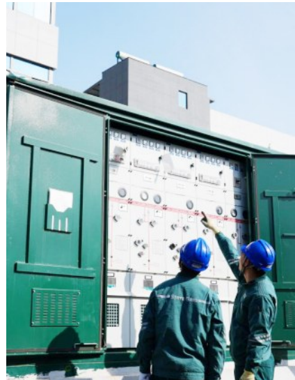
青岛供电公司工作人员对青岛胶州万洋众创城附近的环网柜进行日常巡检。
