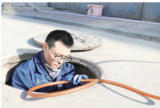
张学下检查井查看供热设施情况。
