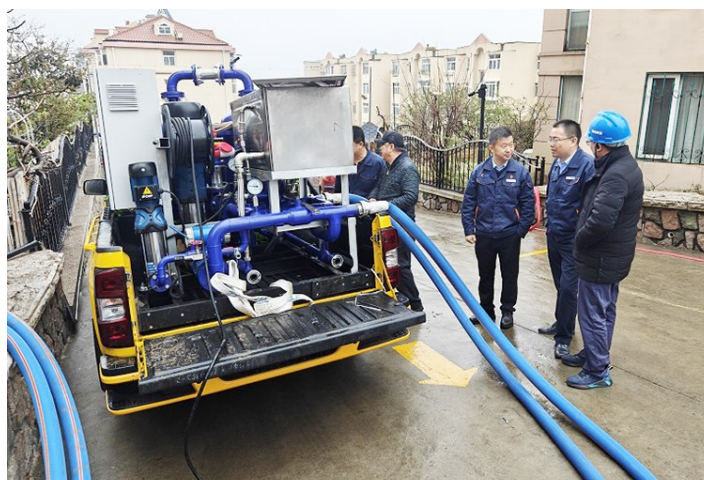
青岛能源热电集团第三热力公司利用管道清洗车在旺海花园小区为居民供热系统进行管道冲洗。
