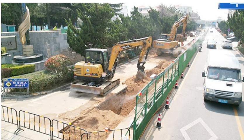
非供热季改造供热管网。
