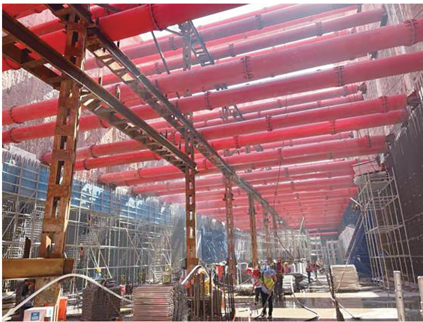
9号线车站施工场景。
