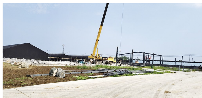
新增违建被拆除。
