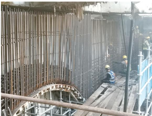
地铁5号线土建二标08工区内工人们正在绑扎钢筋。
