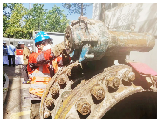
老旧管网改造现场。
