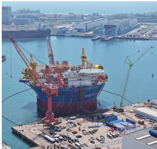
亚洲首艘圆筒型FPSO“海葵一号”建成。
