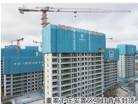
董家下庄安置区项目首栋封顶。
