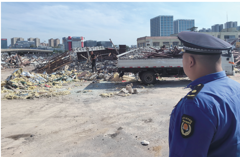
海尔立交桥西侧的一片违法建筑已经被拆除。刘卓毅 摄
