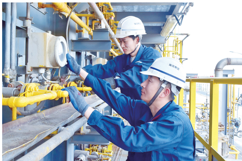
工作人员正在对裂化炉进行检修。 呼扬春晖 摄
