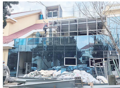
此处二层钢结构房屋被拆除。
