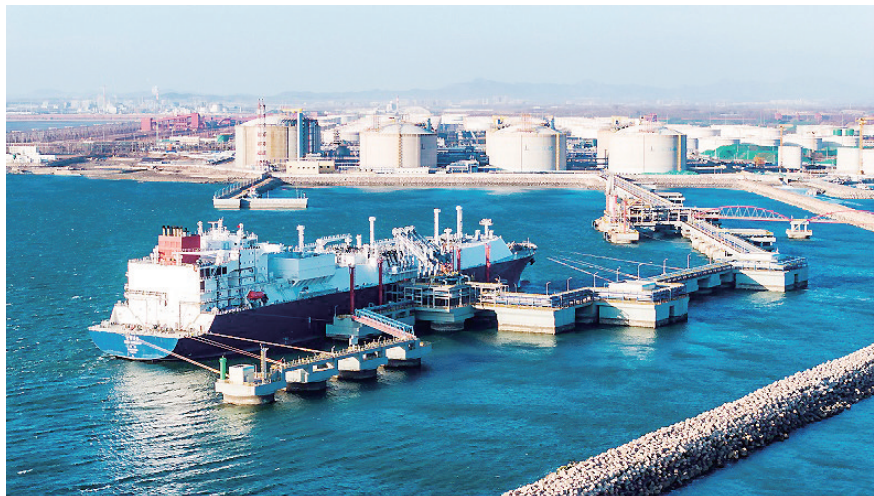
山东省内首座“双泊位”LNG码头正式投用。
