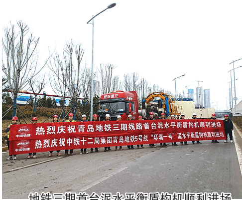
地铁三期首台泥水平衡盾构机顺利进场。
