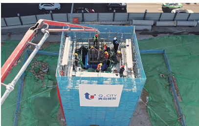
山东路-鞍山路象限连接匝道新建匝道桥首根墩柱完成浇筑。
