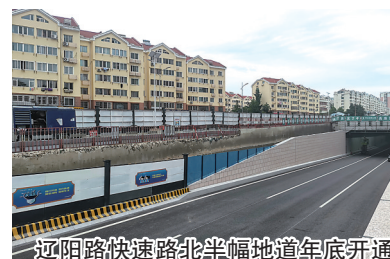
迎阳路快速路北半幅地道年底开通。
