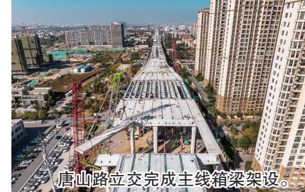
用500吨履带吊双机抬吊配合作业,历时14个昼夜,完成11跨56榀箱梁架设。10月29日24时,该路段按期恢复交通。
