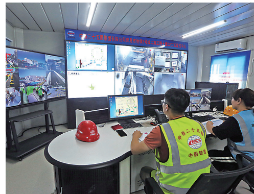
技术人员通过电子监控系统随时掌握盾构机工作运行状况。徐常青 摄
