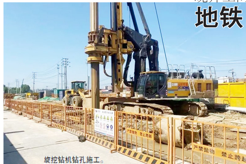
旋挖钻机钻孔施工。
