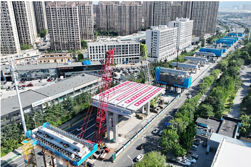
重庆路快速路工程3标段首榀箱梁成功架设。
