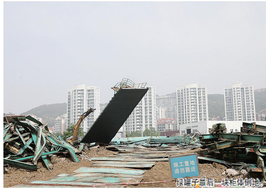
可燃物并涉及高空、动火、吊装等多项危险作业，存在火灾、爆炸、高空坠落、物体打击等风险因素。同时地处较繁华区域且作业空间有限，拆除难度较大，国内可借鉴的拆除经验不多。
