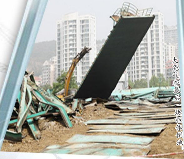
大型作业车在气柜里面开展拆除工作。
