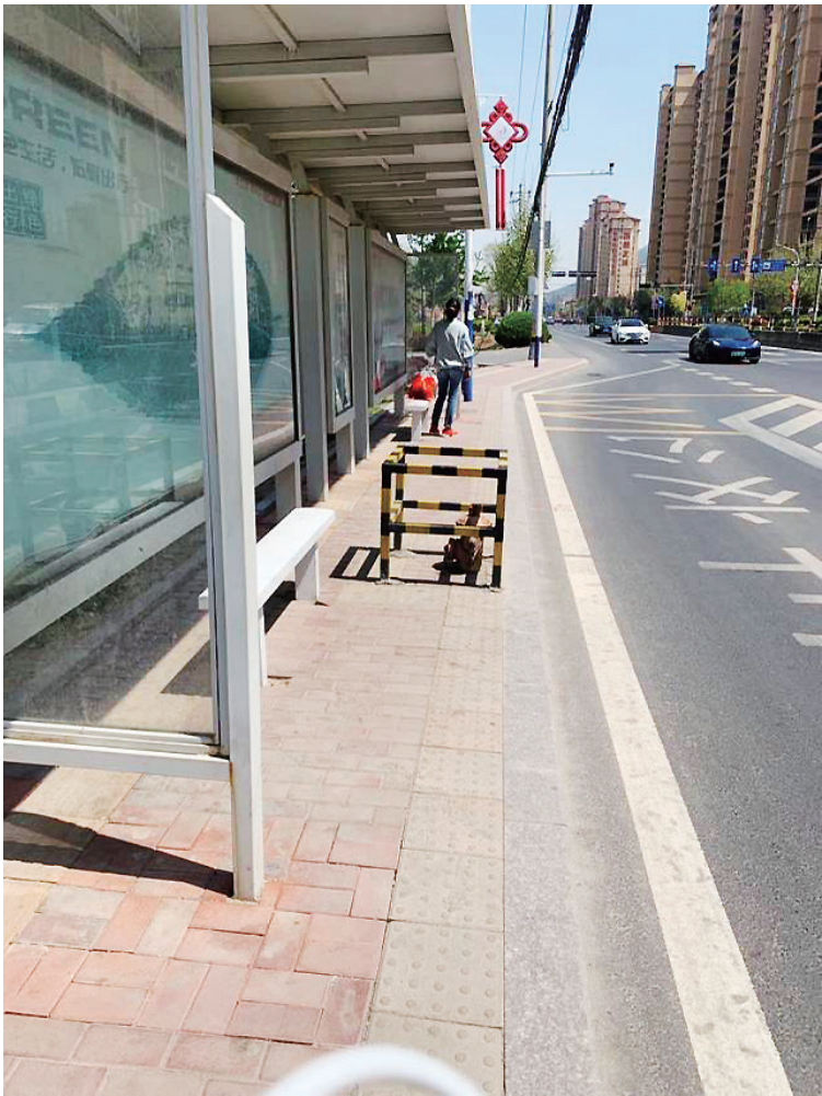
王沙路一公交候车亭内消防栓阻断盲道。
