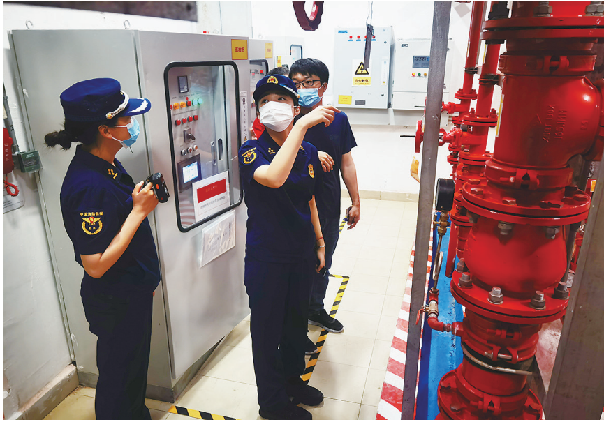
监督员在检查消防设施。刘卓毅 摄
