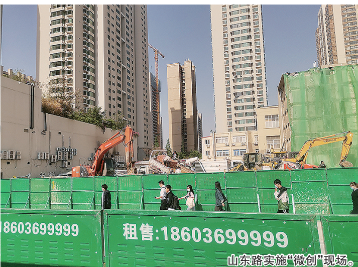
山东路实施“微创”现场。
