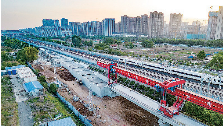
济郑高铁“最后一梁”架设完成。
