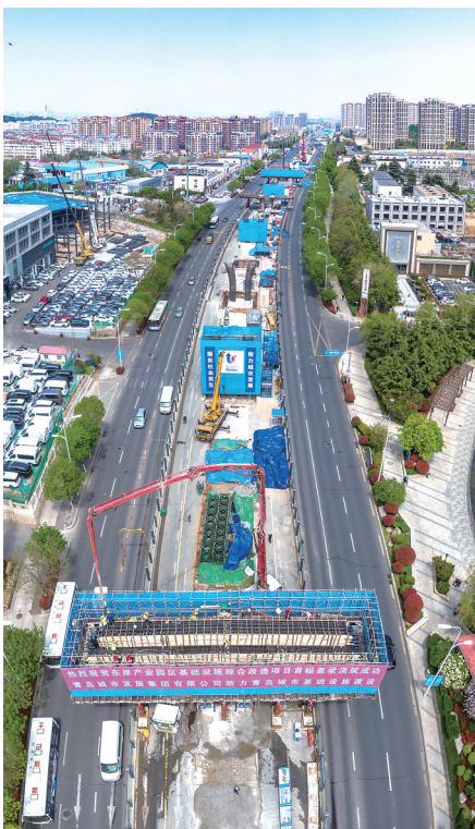
4月24日，重庆路快速路工程全线首榀盖梁成功浇筑。刘栋 摄
