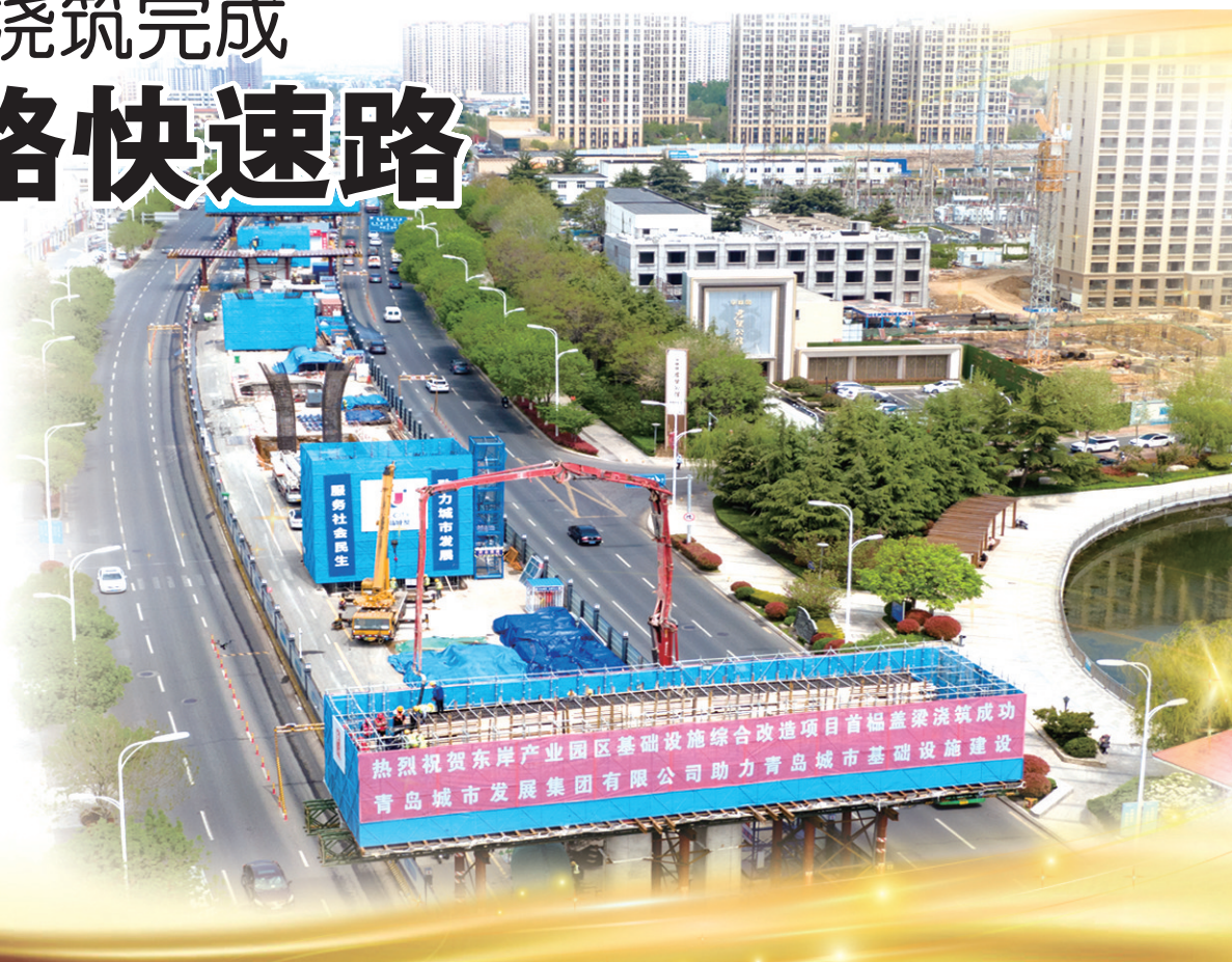
昨日,重庆路快速路工程全线首樁盖梁成功浇筑。刘栋摄
