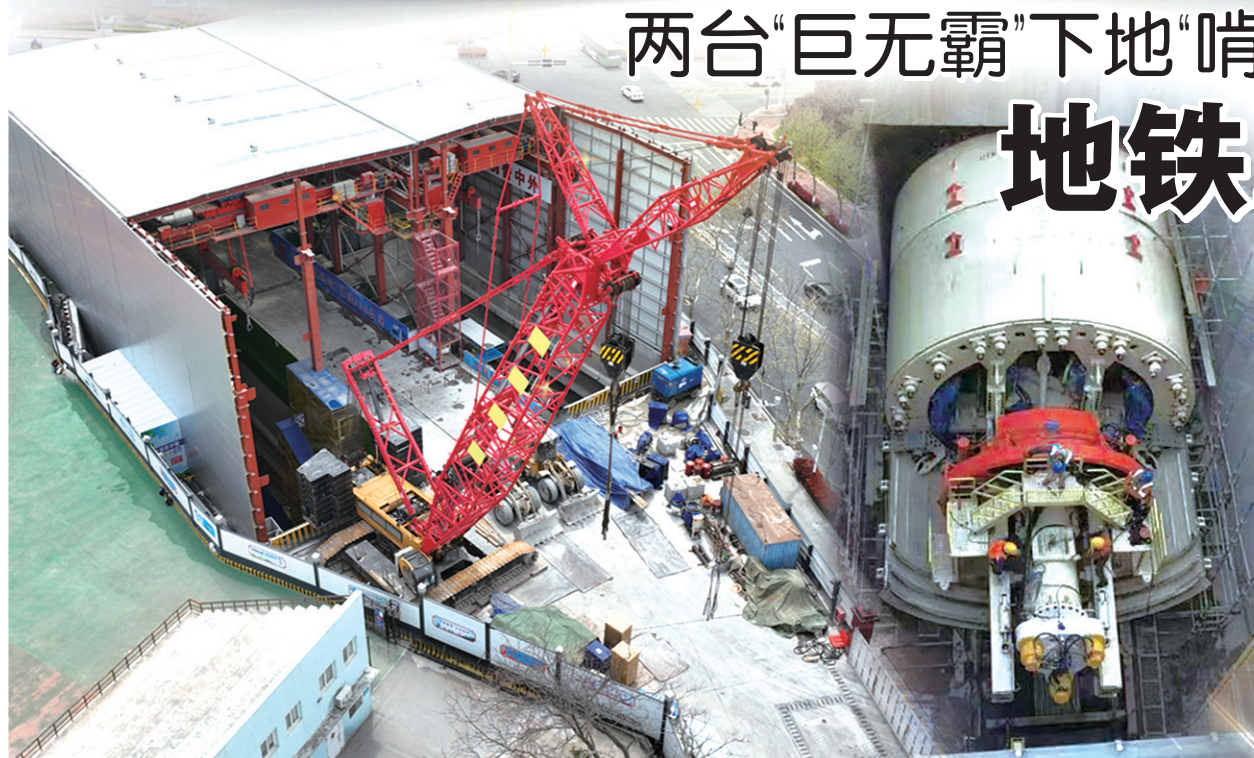
地铁三期TBM、盾构机双始发。
