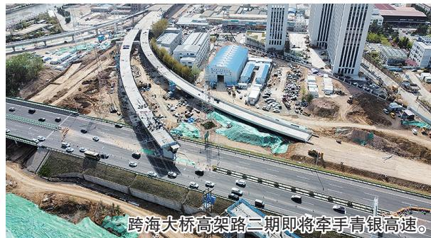
施工吊装箱梁共13节，目前已安装完成8节，每节箱梁重量不一，最重达75吨。
