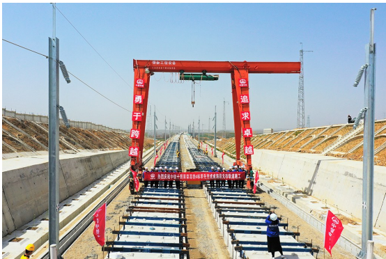
莱荣高铁4标段率先完成威海段无砟轨道施工。
