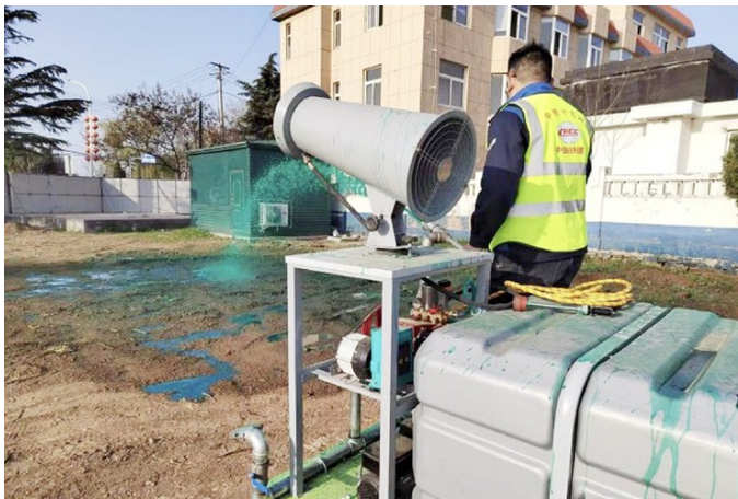
工人正在喷洒新型抑尘剂。
