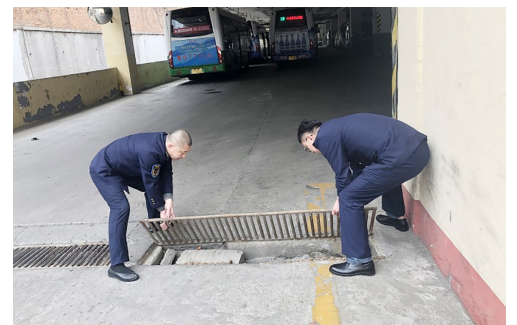
崂山巴士公司工作人员检查下水通道。
