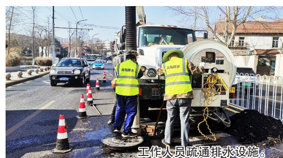
工作人员疏通排水设施。
