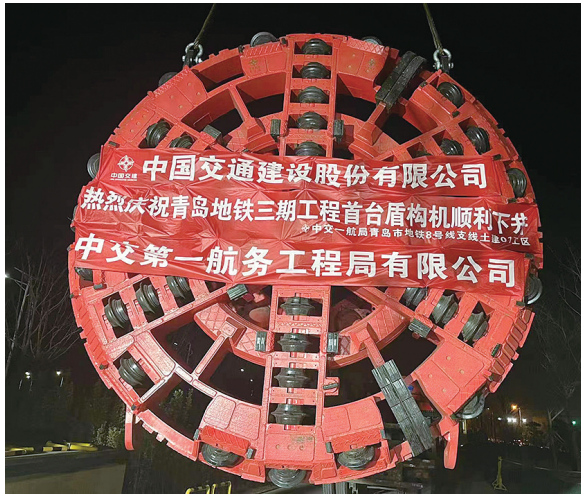
地铁三期线路首台盾构机吊装下井。
