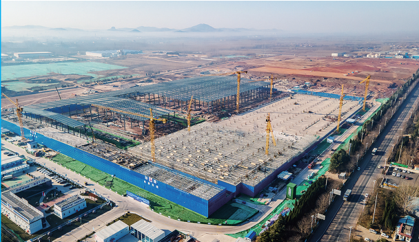
海尔卡奥斯工业互联网生态园施工现场。
