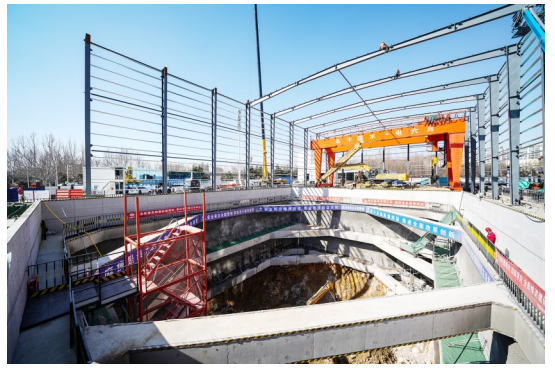
隧道始发井开挖现场。
