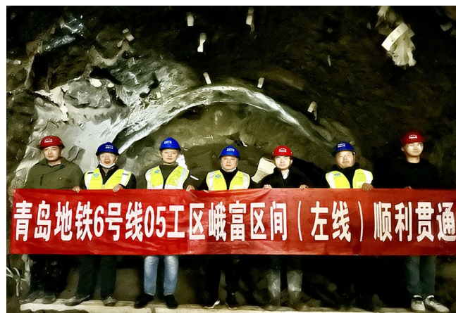
青島地铁6号线一期取得重大进展。
