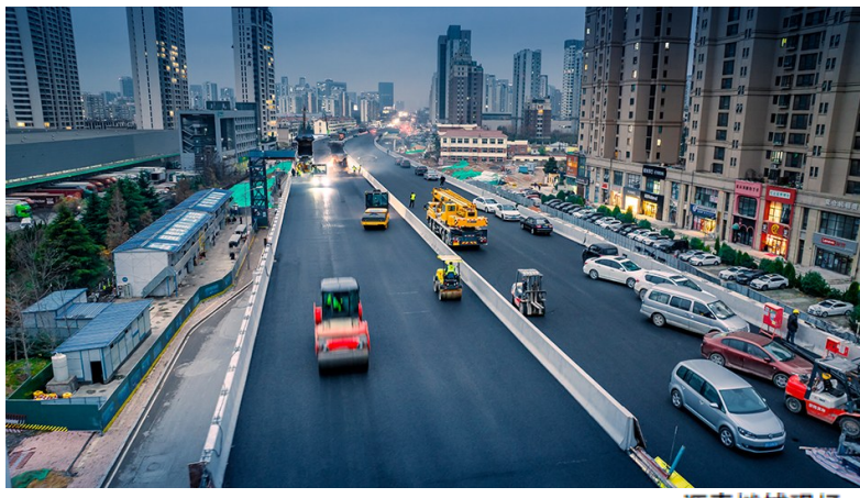
沥青摊铺现场。
