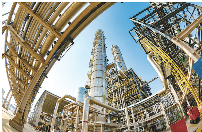
海湾集团厂区。
