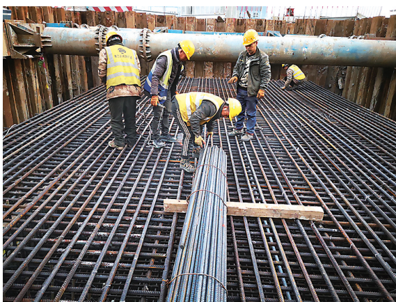
青兰高速项目在施工中。
