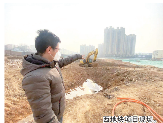
西地块项目现场。
