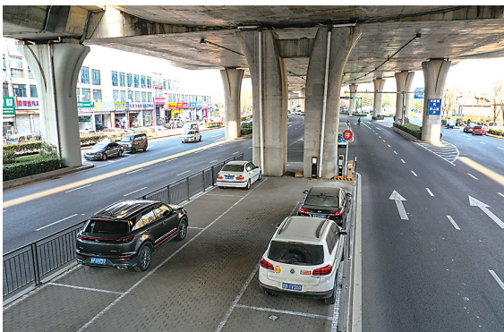
位于重庆路高架桥底的停车场。
