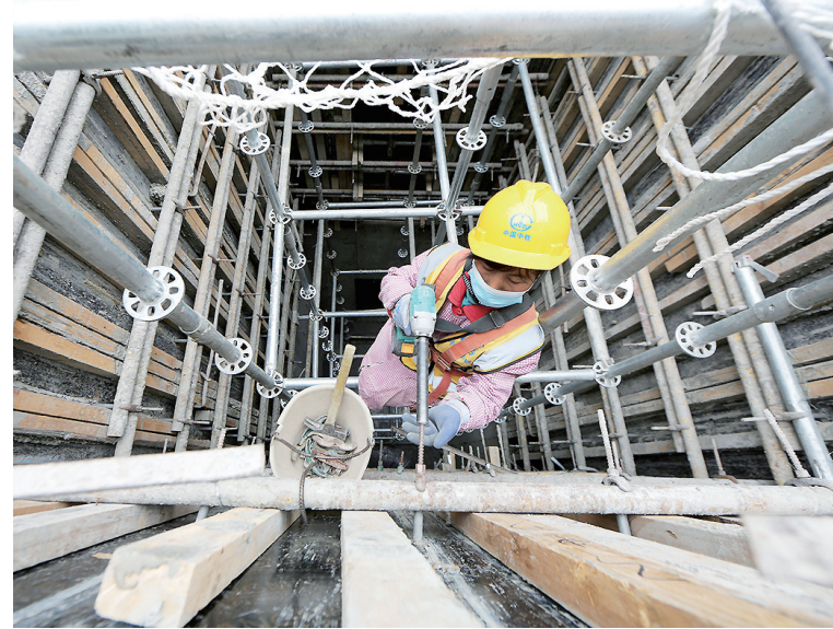
5月8日是母亲节，42岁的木工程习芳正在加固墙模板。
