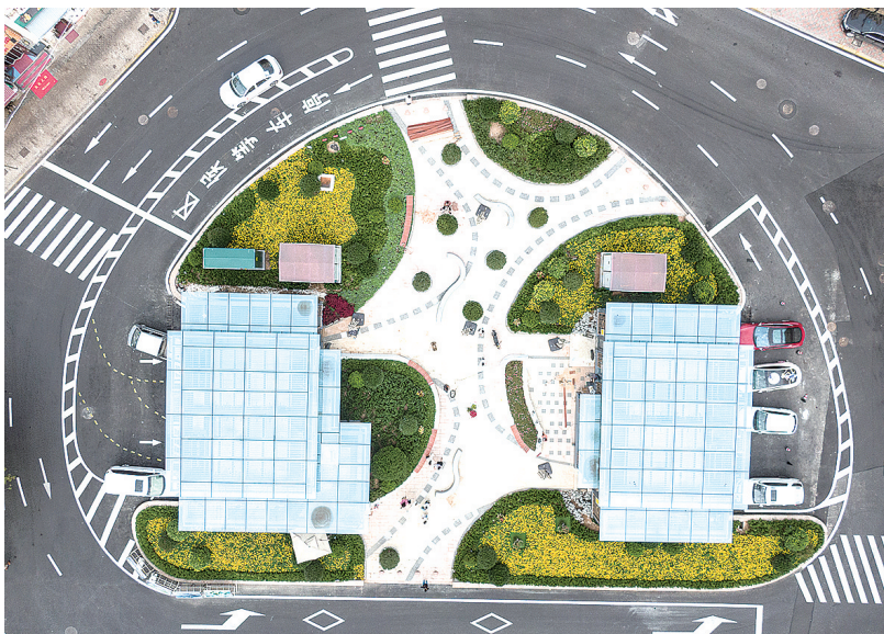
位于历史城区的六街口停车场,采用了地上公园、地下智能立体停车库的设计,缓解周边停车难问题。 刘栋 摄
