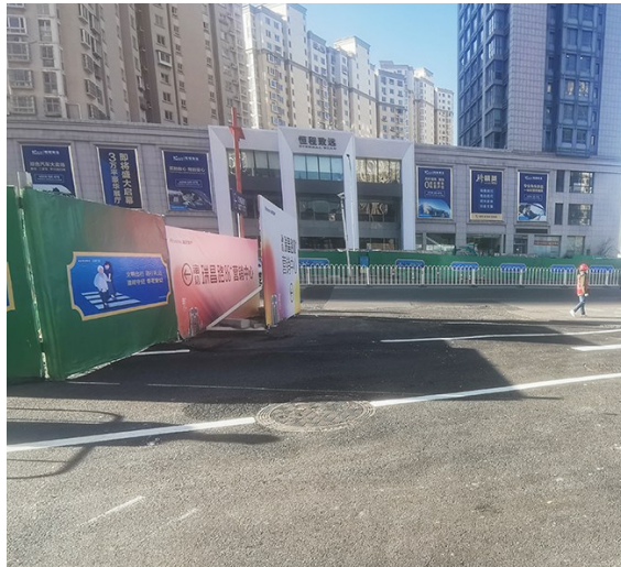
5号线湖岛站验收后就将转入主体施工。
